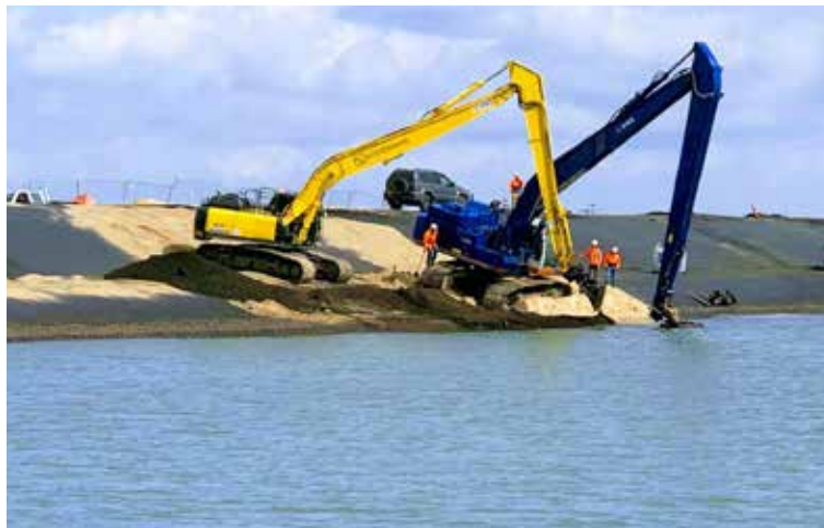
Werken aan de Westdam, kraan door de oude gescheurde asfalt laag gezakt, soms zit het mee soms zit het tegen.
